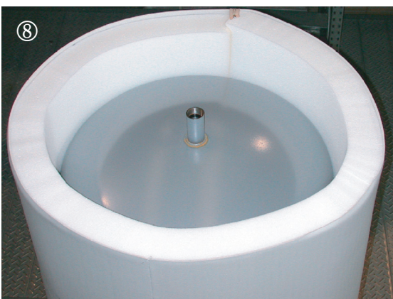
Obrázky znázorňující postup montáže izolace z měkké pěny s PVC fólií na nádrž.
